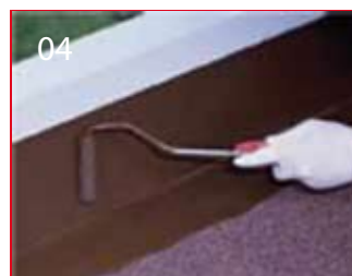
04 Aanbrengen van de tweede laag Alsan Flashing
