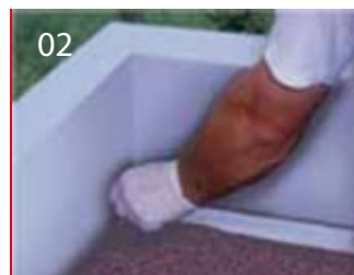
02 Plaatsen van een wapeningsdoek uit polyester met behulp van Alsan Flashing
